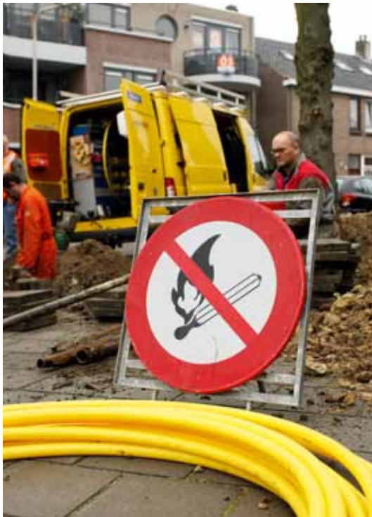
Vervangen aansluitleiding
