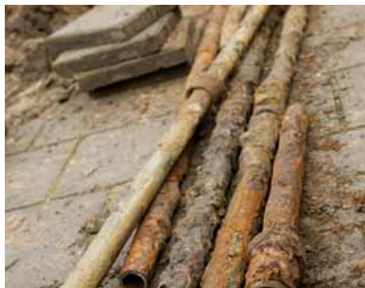
Vervangen aansluitleidingen
