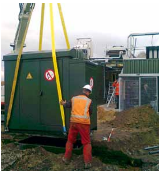
Vervangen gasstation
