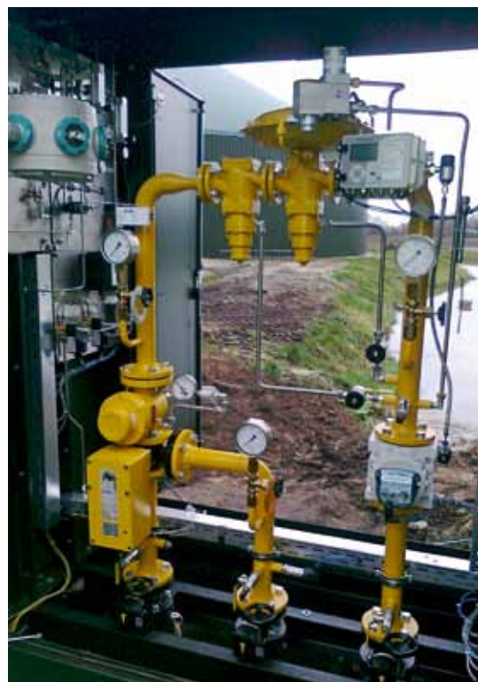
Vervangen gasstation
