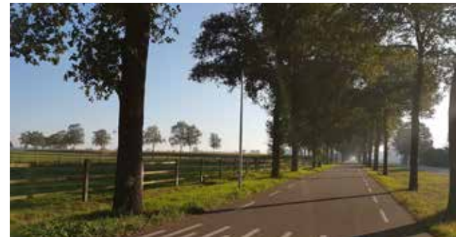
fig. 3.14. Zicht vanaf Holterstraatweg op bomenrij 'De Leiding'
