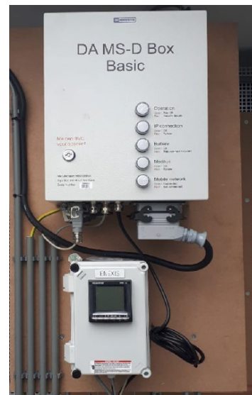
Afbeelding 15: DA-box met DIRIS-meter op montagepaneel
