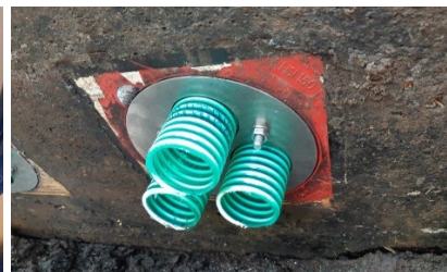
Optie: slangen in 150mm doorvoerplug
