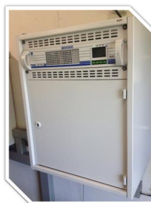
Afbeelding 16: Gelijkrichterkast t.b.v. gelijkspanningsvoorziening
