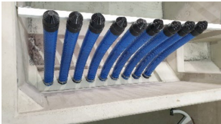
Optie: ingestorte slangtules in compactstation
