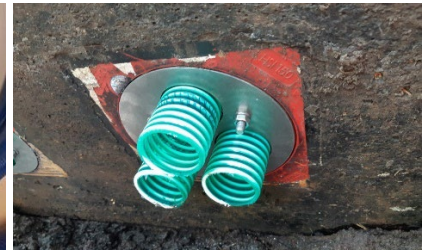
Optie: slangen in 150mm doorvoerplug
