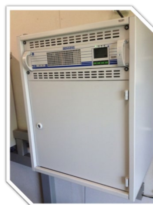
Afbeelding 16: Gelijkrichterkast t.b.v. gelijkspanningsvoorziening
