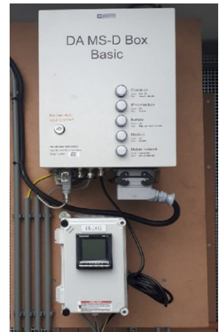
Afbeelding 15: DA-box met DIRIS-meter op montagepaneel
